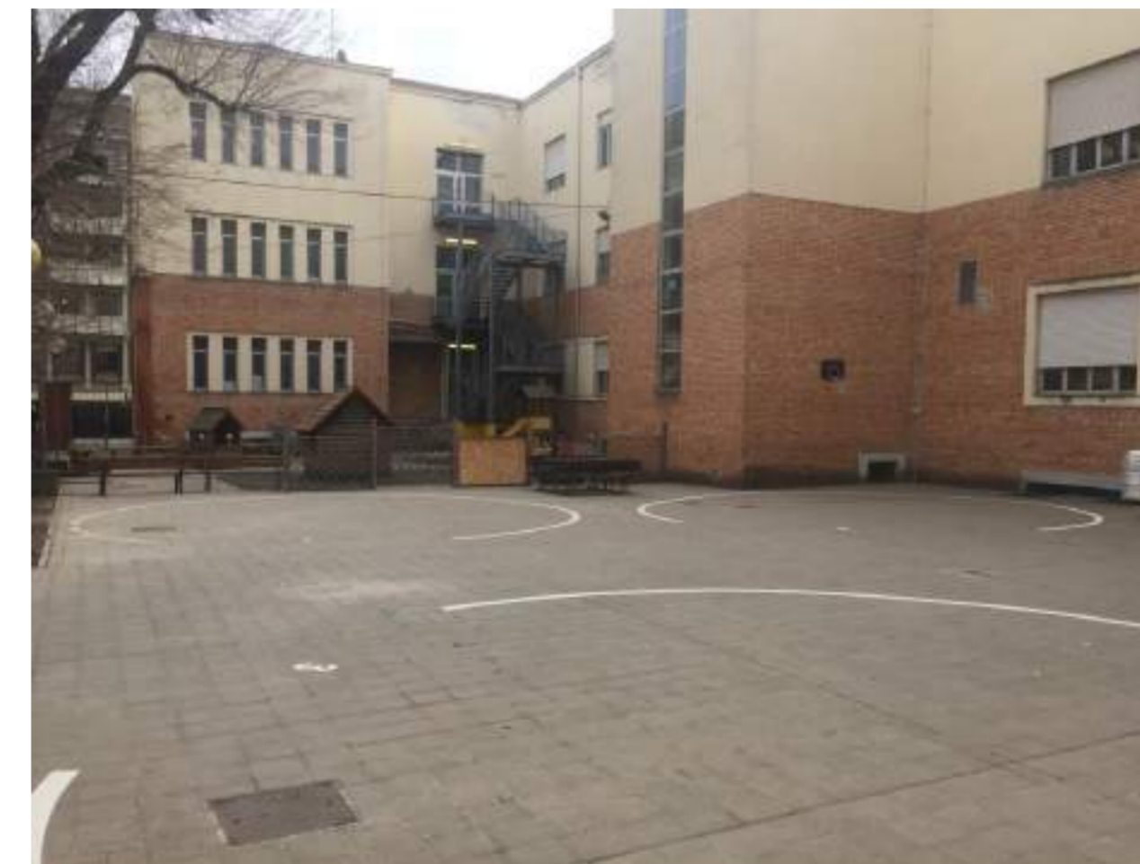
VISTA VERSO SUD-EST
