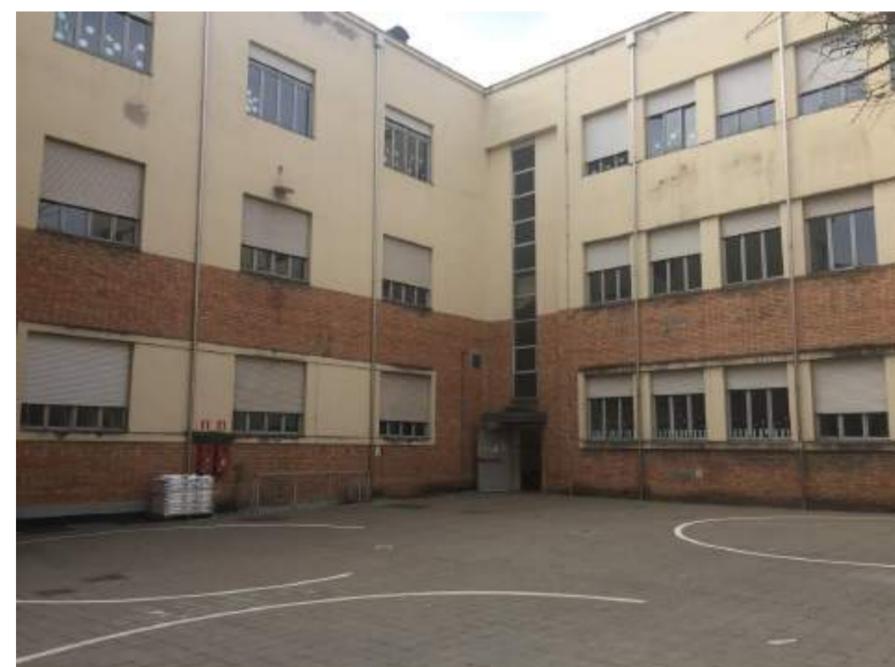
VISTA VERSO SUD-OVEST
